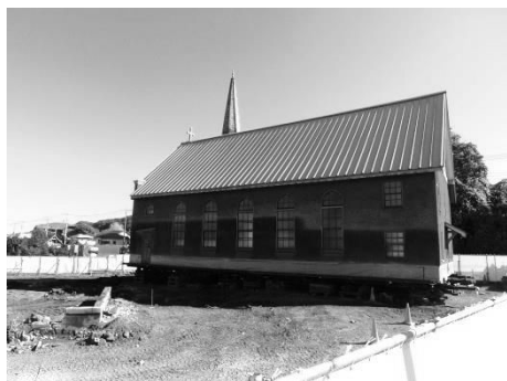
2013. 11 150° 回転 国道側に仮移設
