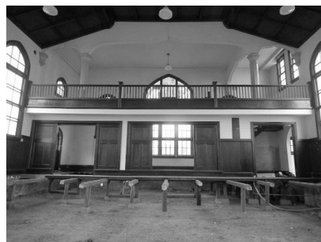
2013. 10 内部解体工事 床組みの撤去
