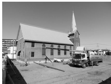
2014. 01 再移設し基礎上に教会堂設置
