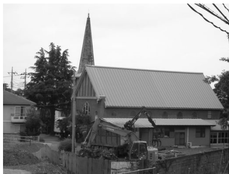
2013. 05 解体工事始まる
