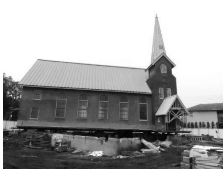
2013. 11 曳家工事 45° 回転
