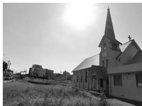
2014. 06 教会堂建築工事完了
