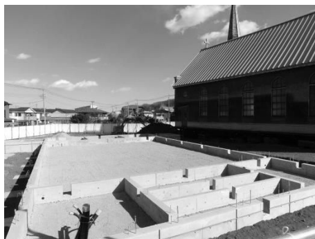
2014. 01 新設基礎工事完了
