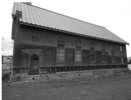
2013. 10 柱脚部、土台補修補強工事
