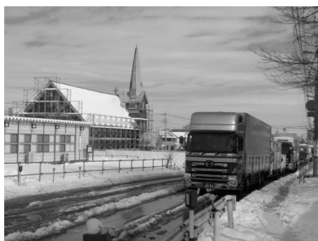
2014. 02. 09 大雪 足場が設置されている
