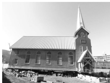
2013. 11 曳家工事 100° 回転
