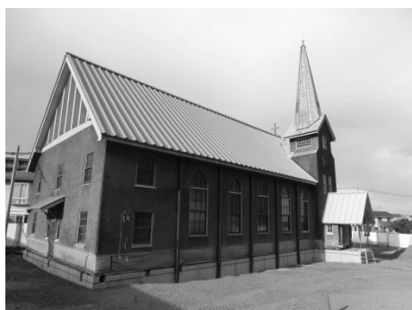
2014. 01 耐震補強工事 鉄骨添柱
