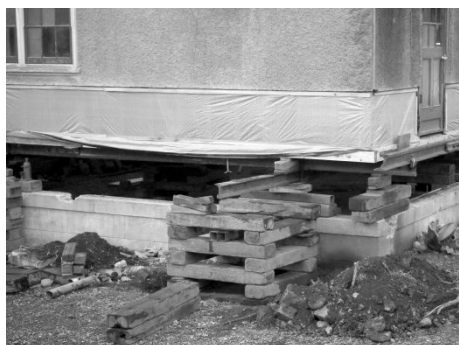
2013. 11 曳家工事 基礎と分離
