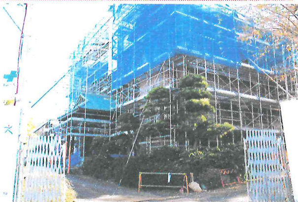
改修工事の進む西洋館(外観)
