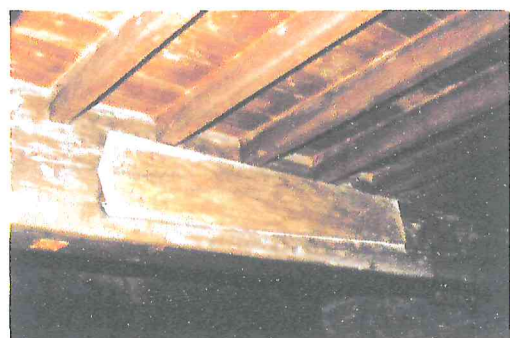
第3図 棟札の西洋館地下貼り付け状況
